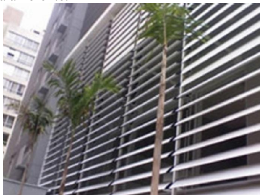
Figura 1. Modelo brise horizontal móvel (site AMBIENTAR).
