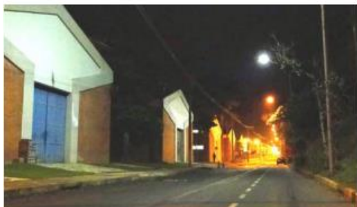
Fig.3 Iluminação noturna de parte do anel viário com LEDs, em primeiro plano, e com VSAP, ao fundo.
